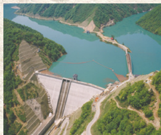
境川ダム工事
