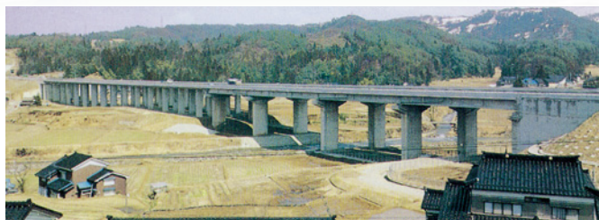
北陸自動車道湯上高架橋工事
