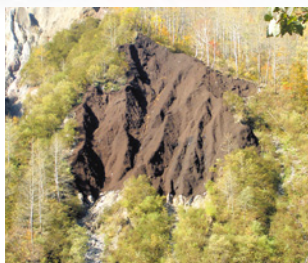
水谷沢山腹工事 平成14年
