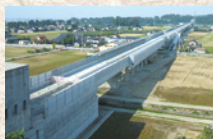
魚津六郎丸高架橋
