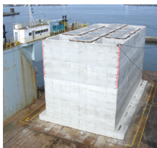
伏木ケーソン
