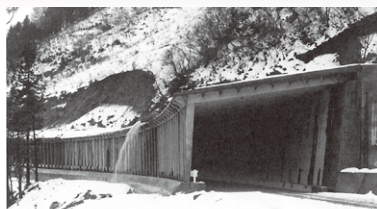
一般国道156号線道路改良工事井波町大橋平地先
