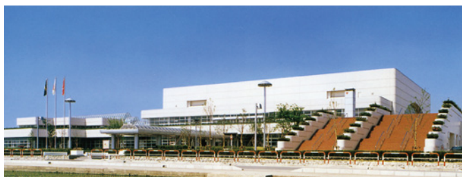
富山県総合体育センター 昭和59年
