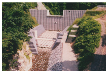
◀庄川水系和田川砂防ダム
