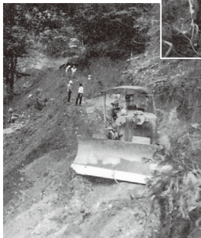
峯越連絡林道開設事業ブナオ線全工区工事
