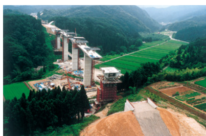
◀東北陸自動車道 上原橋
